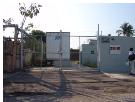
FOTO 30: Instalaciones de TELMEX.
