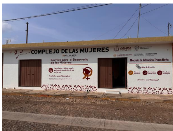
Ilustración 3 Fachada Centro de Atención Inmediata Coquimatlán
